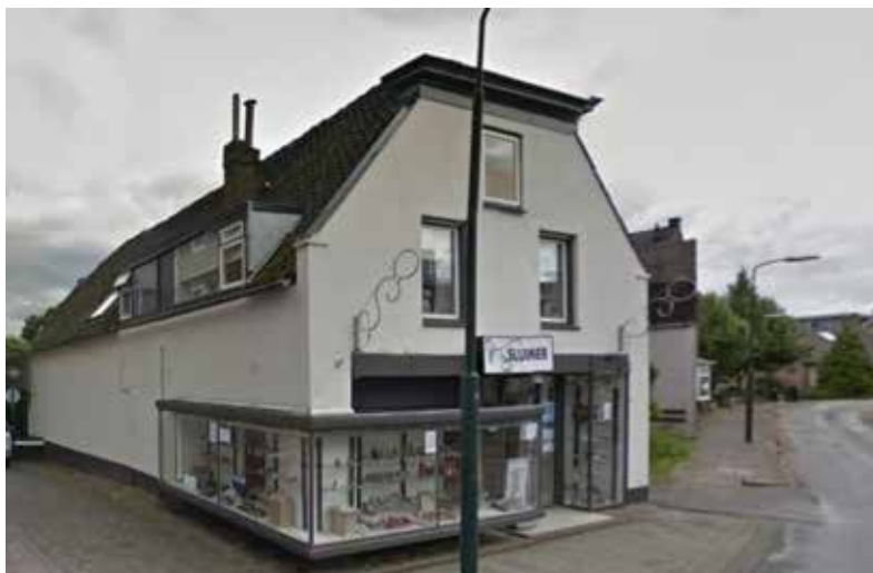
De voorgevel van het pand is geheel witgeverfd/gepleisterd. Op deze manier was het mogelijk om de contouren van de oude dichtgemetselde kerkraden weg te werken. Het pand zoals velen dat nog herinneren: Sluimer schoenen, een begrip in Giessendam.
