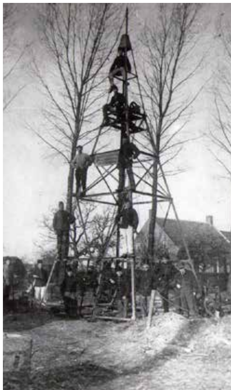
De firma Hoogendoorn krijgt in oktober de opdracht om een pompbuis te slaan ten behoeve van de keukenwagen van de 5e batterij, 3e regiment veldartillerie. Deze foto is gemaakt voor de boerderij op Haansberg 17 te Etten-Leur. De boormeester op deze klus is Arie van der Plas
