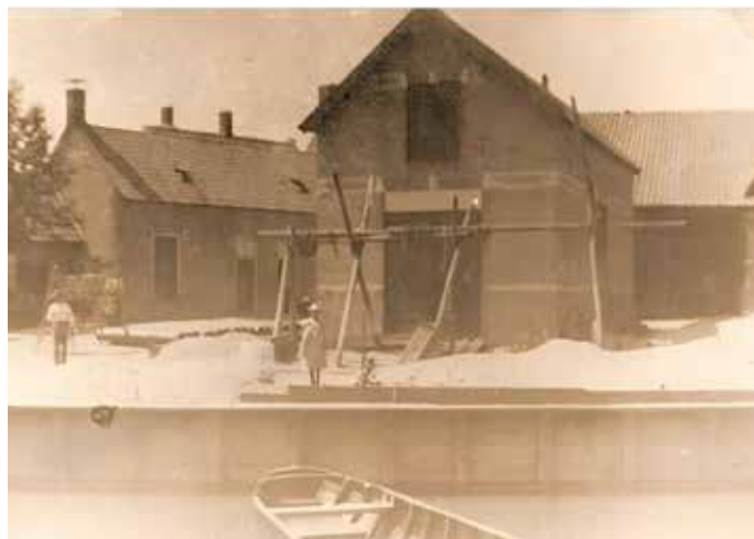
Het pomp- en putboorbedrijf van N. Hoogendoorn. We zien links een groot aantal boorbuizen liggen. Veel materiaal werd per schip vervoerd naar de plaats waar geboord moest worden. De foto is rond 1930 in de buurt van Buitendams 25 genomen
