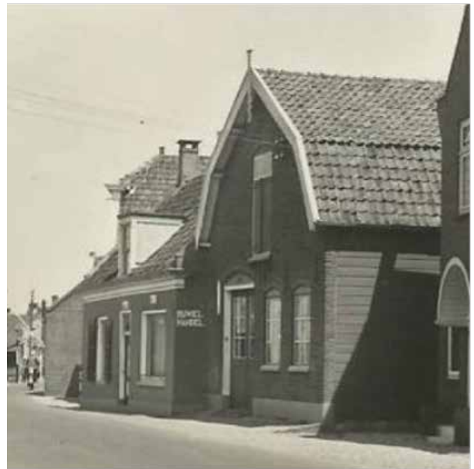
Een foto van de situatie rond 1960. Het huisje met het raamkozijn op dijkniveau is inmiddels vervangen door het pand met de gebroken kap waar, zoals op de foto te zien is, de rijwielwinkel is gevestigd. Buitendams 39 staat er hier nog links van, wordt snel na het nemen van deze foto afgebroken.
